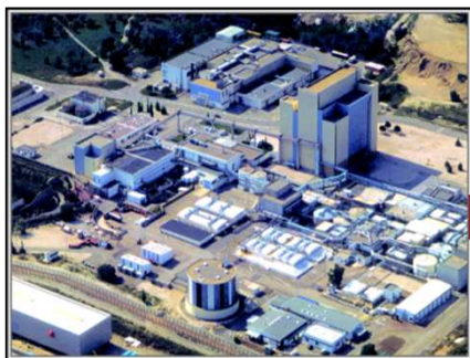
Traitement des Effluents Liquides de Marcoule
