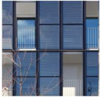
Intégration solaire thermique
