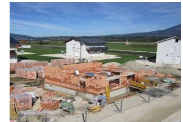
Maison expérimentale pour test de l'enduit aérogel
