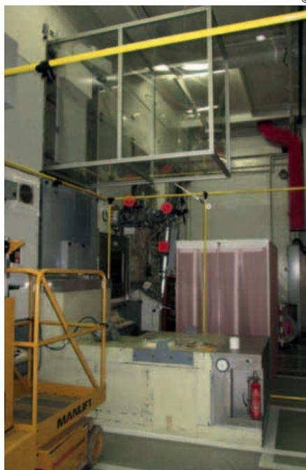
Pétrus : en préalable au démantèlement de l'ensemble Pétrus, un tunnel de transfert entre deux chaînes a dû être déposé (bloc jaune en bas gauche).
