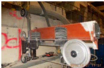
Bâtiment 52, découpe d'un voile (mur) en béton à la scie à câble diamanté (vue générale et vue rapprochée).
