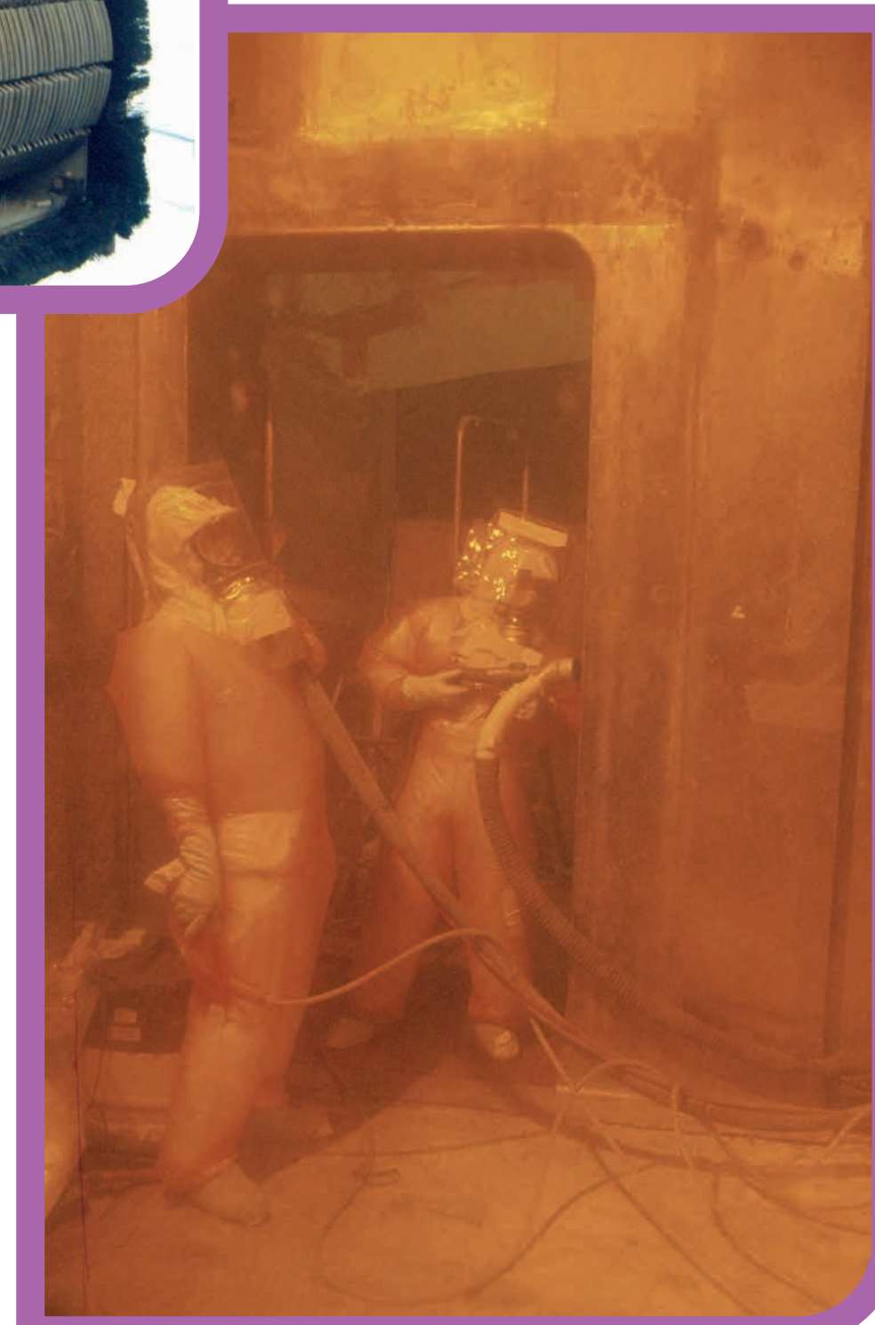
La raboteuse et la technique du sablage sont utilisées afin d'enlever de fines couches de béton ou de métal.
