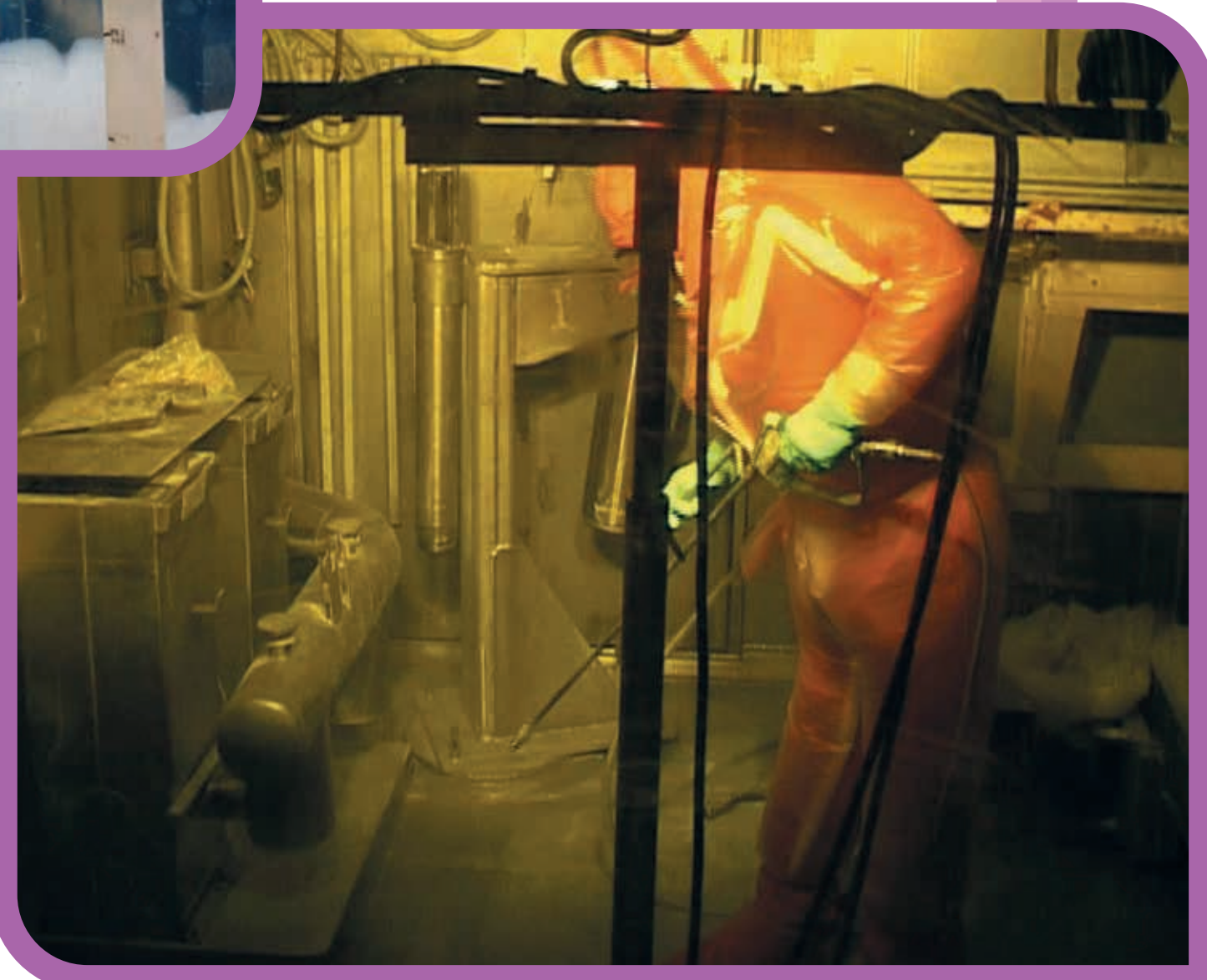
Gel/mousse : matériaux dans lesquels se fixe la radioactivité.
