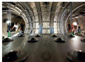
Pose du boîtier de la bobine basse du divertor West
